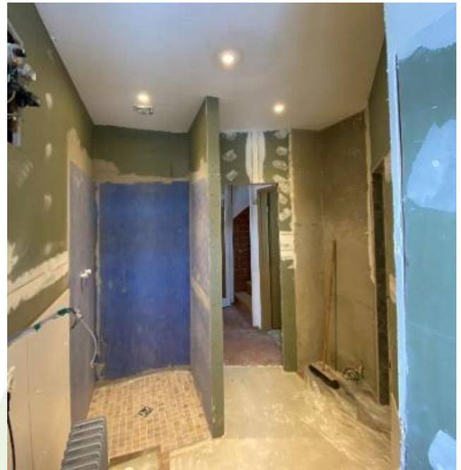
Zwischenstand von der Sanierung mit Umsetzung der Dusche, @ A. Körting
